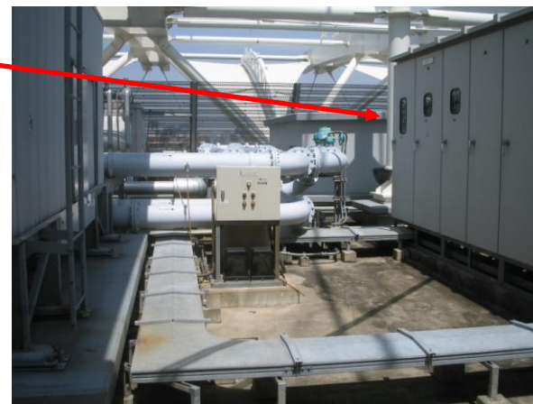
既存冷却塔ファン動力盤
